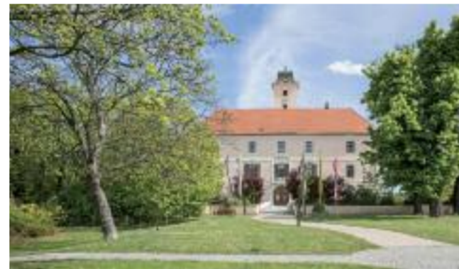
Das Wasserschloss in Vösendorf wurde neu renoviert.
