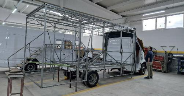
Der Aufbau auf das Chassis beginnt.
